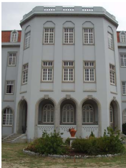
Pormenor da fachada do edifício
