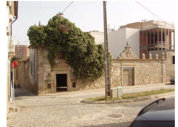
Vista Geral da Capela de S. Victor-o-Mártir
